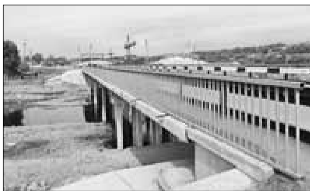
■ Благодаря поддержке Ефремова построен мост в Подюге
